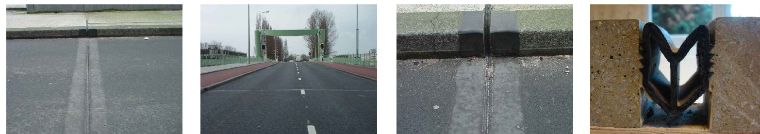
Principe doorsnede voetpad Rubberprofiel type FW
